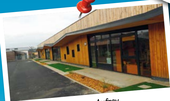
Extension école Hugues Aufray
