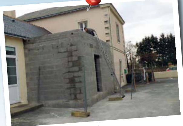
Travaux extension mairie
