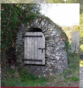
Puits La Croix
