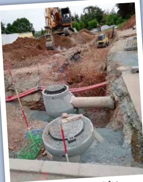
Chantier lotissement Saint-Jérôme
