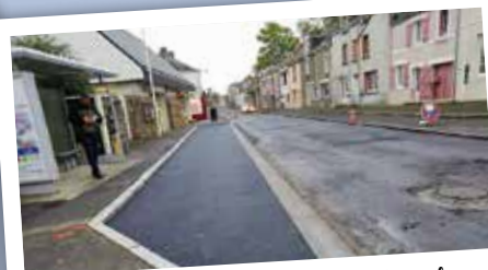
Réfection stationnement de l'arrêt de bus - bourg
