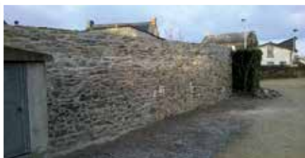
Réfection du muret du cimetière
