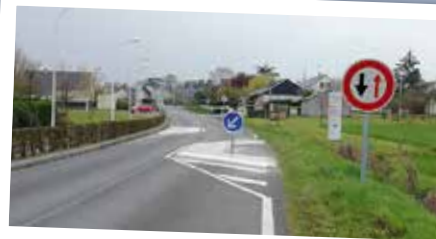
Création de chicanes entrée du bourg RD21
