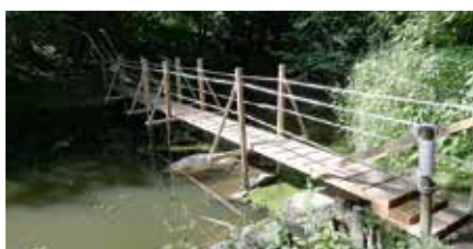
Réfection de la passerelle du Pont Noyer
