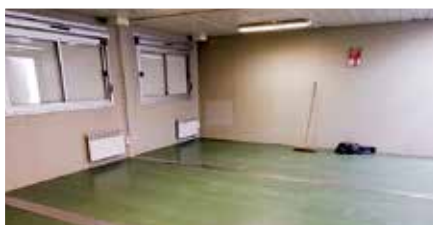
Réfection du plancher du bungalow palets
