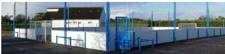
Création d'un terrain de foot à 5
