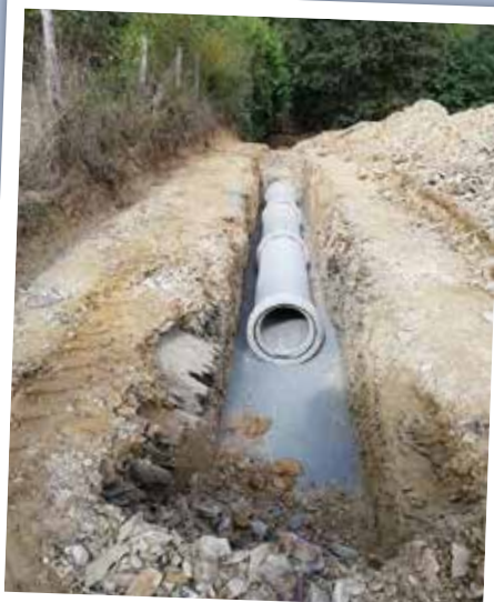
Création busage vers le ruisseau des Nones (bois sur l'eau)
