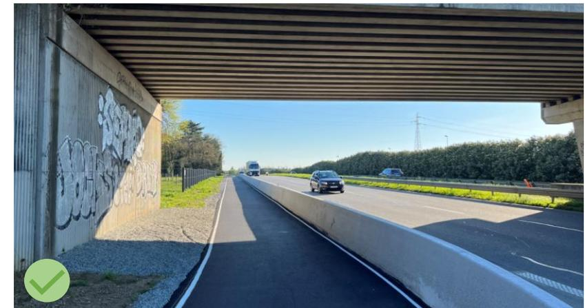
*Piste cyclable bidirectionnelle avec séparateur béton le long d'une 2x2, réflecteur dans le virage sur la glissière – Noyal-Châtillon (35)*
