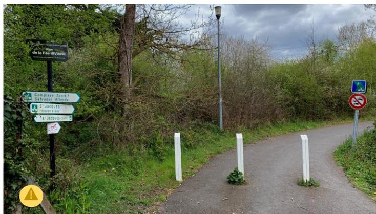
Éléments réfléchissants à ajouter au dispositif anti-intrusion – St-Jacques-de-la-Lande (35)
