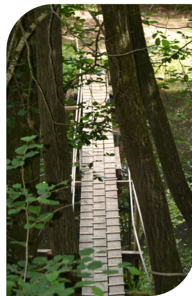
Passerelle du Pont Noyer
