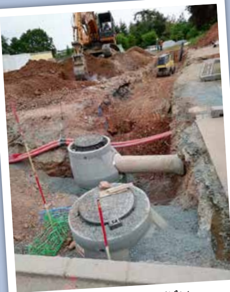
Chantier lotissement Saint-Jérôme
