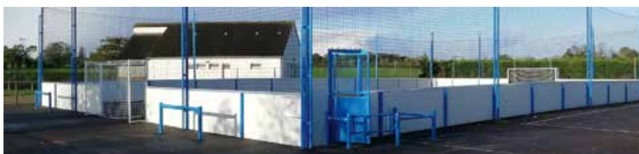
Création d'un terrain de foot à 5
