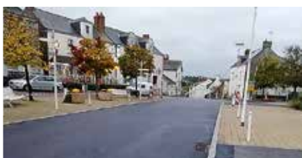
Réfection de la chaussée par le Conseil Dép. 44
