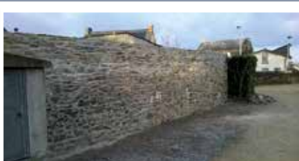
Réfection du muret du cimetière
