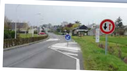
Création de chicanes entrée du bourg RD21
