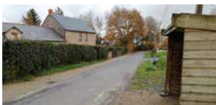
Sécurisation cheminement piétonnier au Bas-Vieux-Couffé
