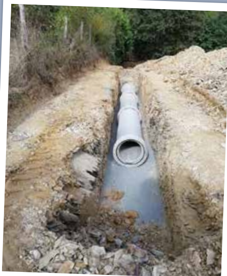
Création busage vers le ruisseau des Nones (boi sur leau)
