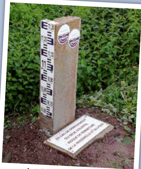
Installation d'un repère de crue Passerelle du Beusse
