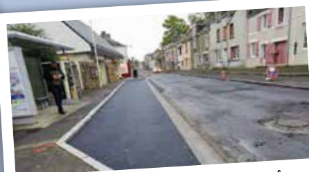
Réfection stationnement de l'arrêt de bus - bourg
