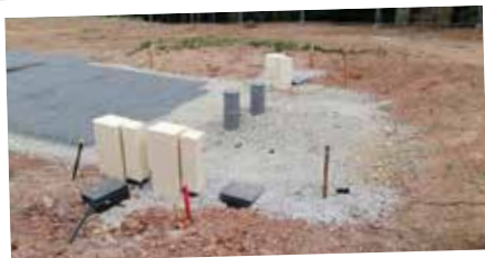
Chantier lotissement Saint-Jérôme
