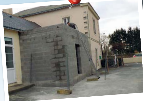
Travaux extension mairie
