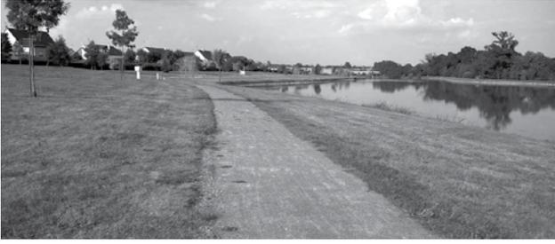
Dans le cadre de la démarche 0'phyto engagée en 2015, le service technique de la commune de Couffé a réalisé un renforcement en sable d'une partie de l'allée piétonne du plan d'eau. Ceci afin de permettre un désherbage mécanique et donc limiter l'utilisation de produits chimiques.
