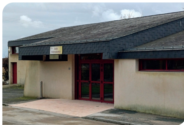
Salle polyvalente : entrée PMR
