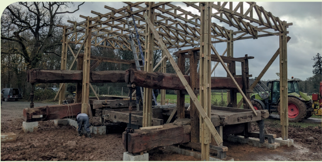
Abri des pressoirs en cours de remontage
