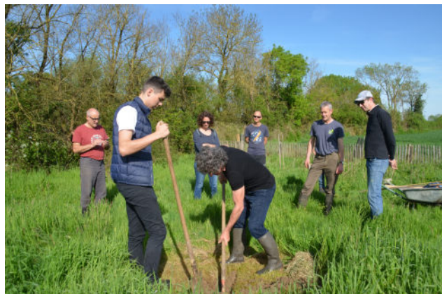
Installation de la clôture
