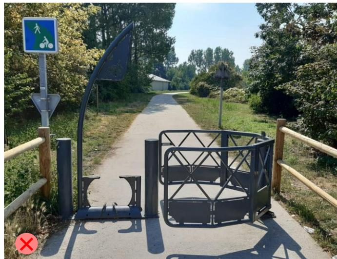
Dispositif anti-intrusion inadapté, excluant les vélos cargo, les carioles et pénalise les piétons avec poussette ou UFR
