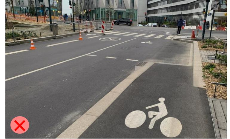
*Fin de piste cyclable en sas vélo, insertion violente dans le flux motorisé, risque d'accident sans contrôle d'angle mort – Rennes*
