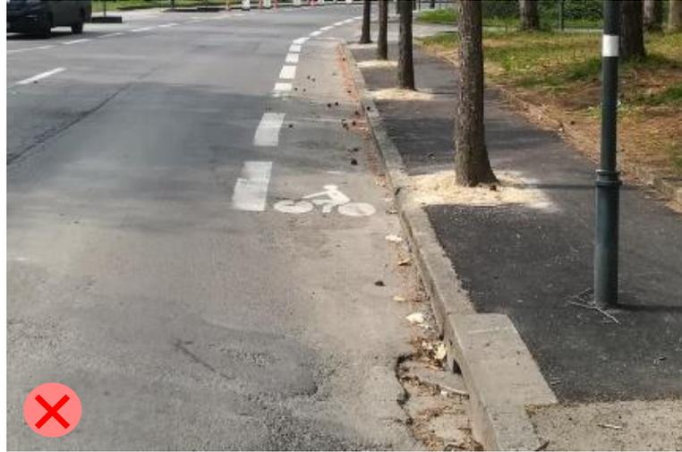
Bande cyclable dégradée, potentiellement non-utilisée
