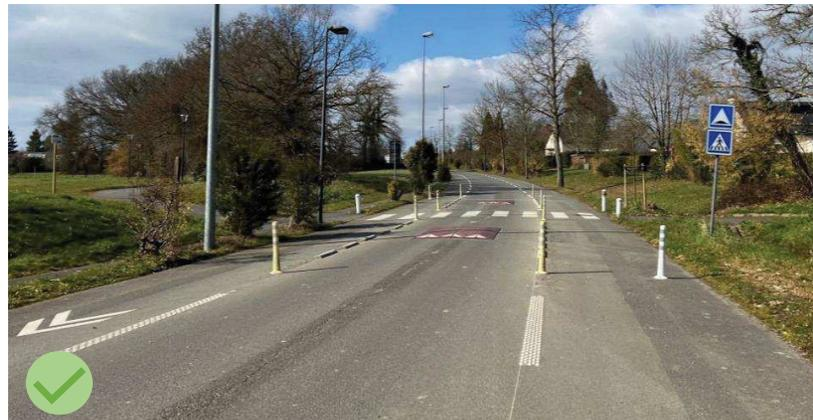
CVCB avec écluse et passage alterné motorisé au niveau d'une traversée – Noyal (35)
