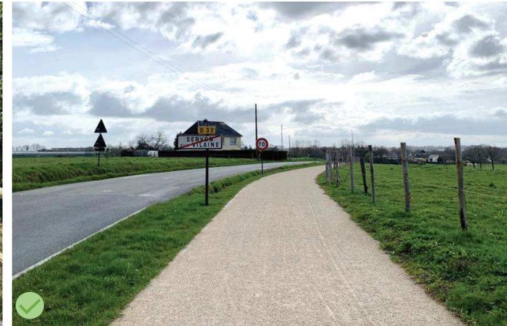
Voie verte en stabilisé contiguë à la chaussée avec séparateur d'un mètre – Sevron-sur-Vilaine (35)
